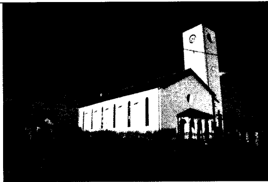
Remont Kościoła p.w. Św. Wawrzyńca w Sapolnie polegający na remoncie elewacji, zmianie konstrukcji i wymianie pokrycia dachowego wieży kościoła, portyku i absydy
